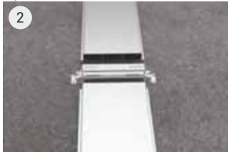
2 Соедините между собой кабельные каналы.
