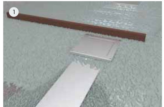
7 Вставьте кабельный канал в соединительное отверстие
