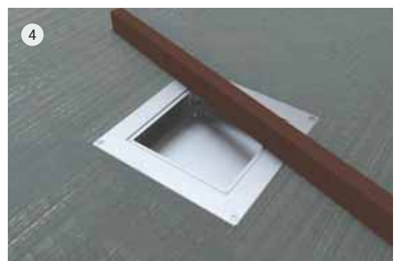
11 Выполните укладку раствора выравнивающей стяжки. Заполните область вокруг лотков и распределительных коробок, чтобы не оставлять пустоту под ними.
