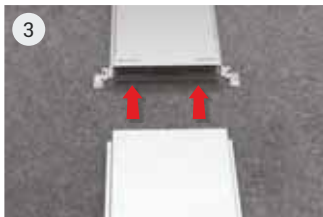
3 Дополнительный элемент подсоедините к концу канала
