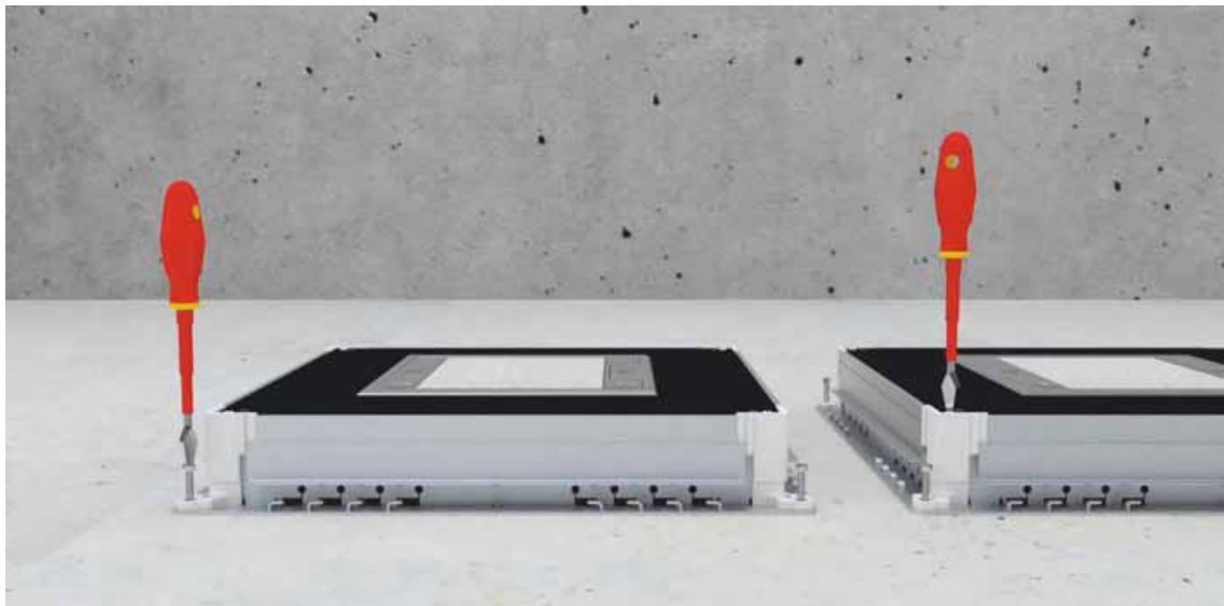
Высота установки до укладки стяжки (20 мм)
