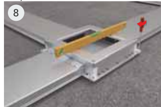
8 При помощи нивелира отрегулируйте уровень соединительной коробки
