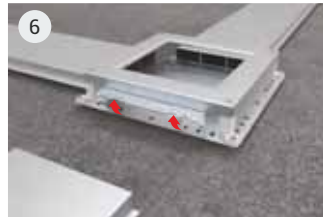
6 Отогните металлическую пластину для стыковки кабельного канала.
